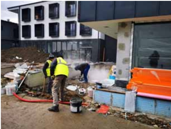
Arbeiten im Hof
